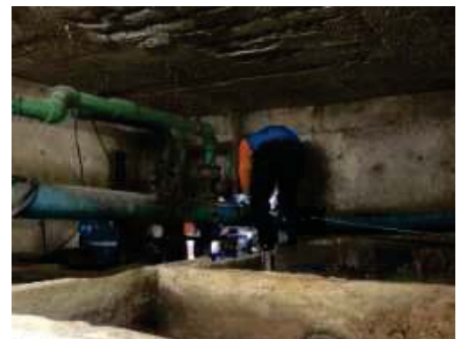
สูบน้ำและไขมันระบบบำบัดน้ำเสีย
