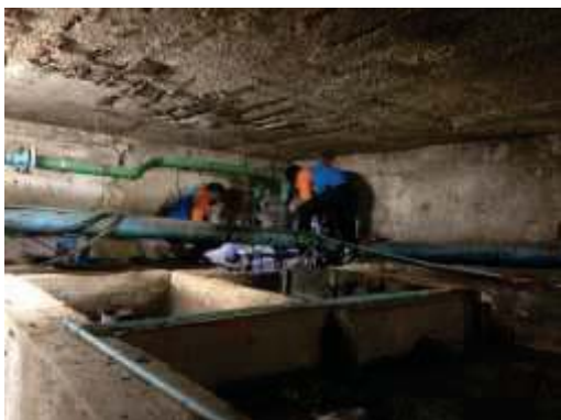
สูบน้ำและไขมันระบบบำบัดน้ำเสีย
